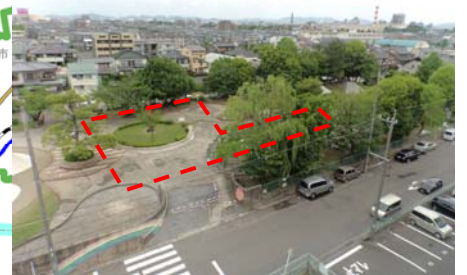
春日井市 はなのき公園(地下) (容量約3,000m 3 ) 本年度着工
