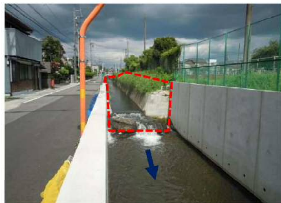
⑤原川：護岸工事
