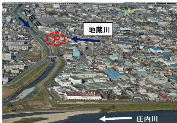
⑦地蔵川：排水機場建設予定箇所
