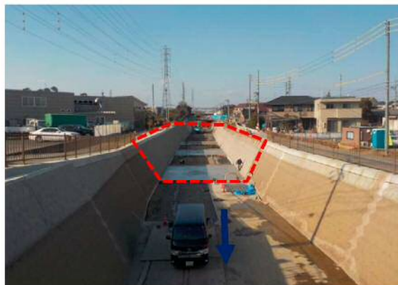
⑧薬師川：護岸工事
