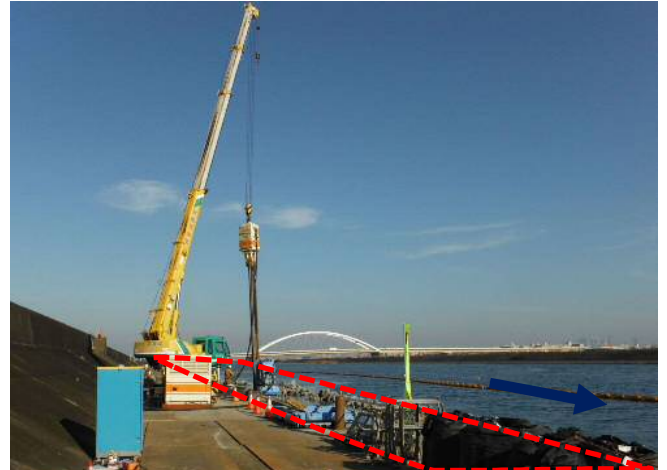
①-2新川：堤防耐震化工事の状況
