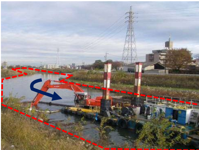
②五条川：浚渫工事の状況
