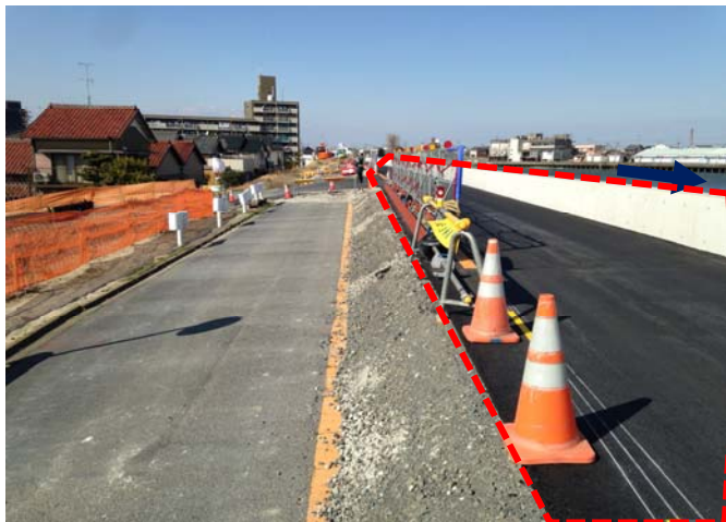
①新川：堤防嵩上げ状況
