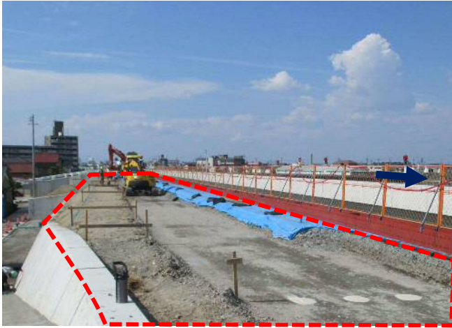
①-1新川：築堤・護岸工事の状況
