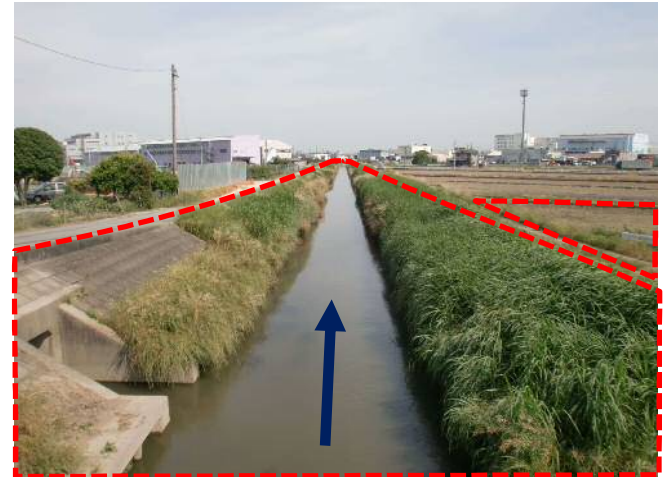
③水場川：今後の改修区間及び調節池予定地
