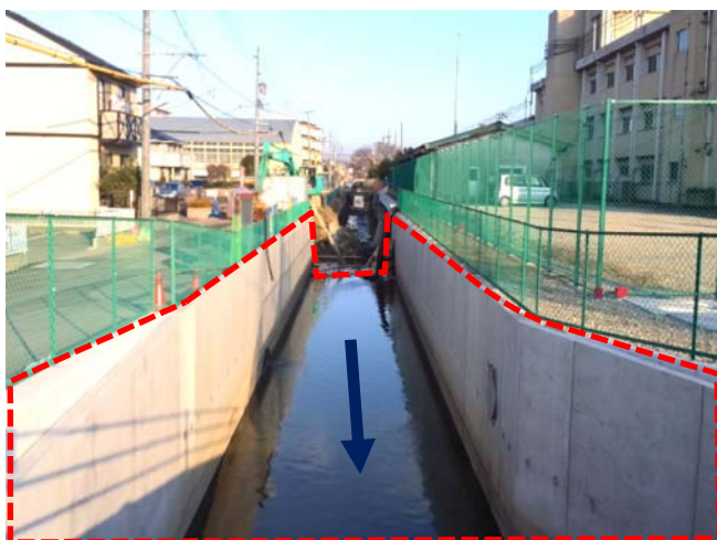
⑤原川：河道拡幅の状況
