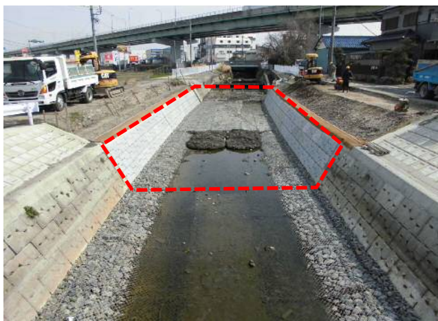
④-1中江川：河道拡幅工事の状況
